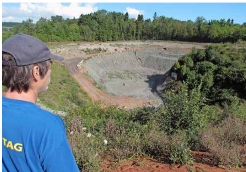
Da die Bedingung einer neuen Zufahrtsstrasse erfüllt ist, kann die Deponie nun mit knapp einer halben Million Kubikmeter Schutt gefüllt werden.
