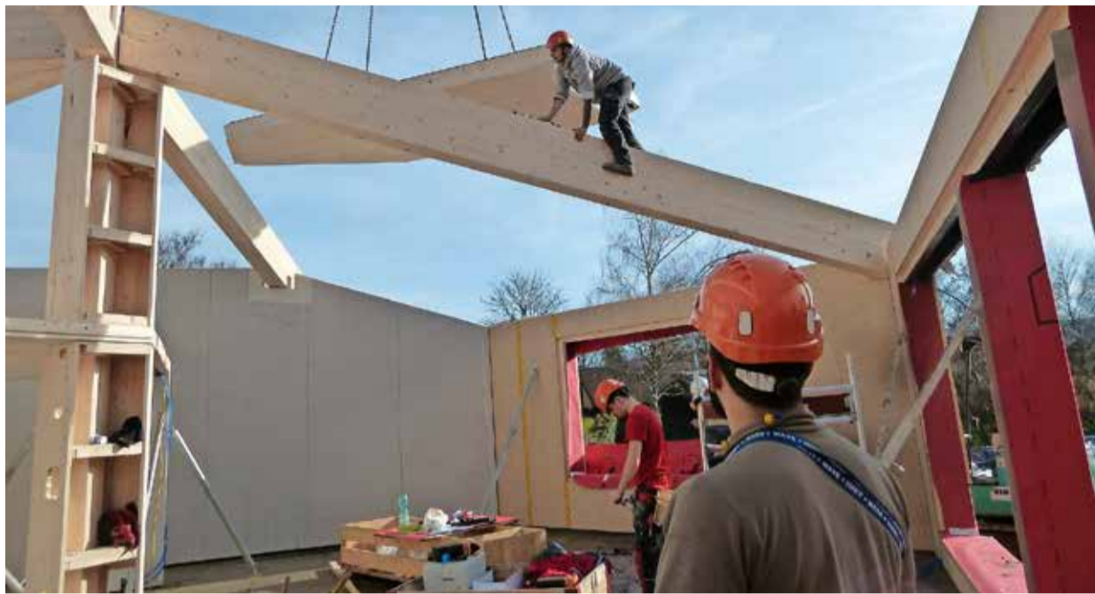
Auf den Balken balancierend setzen die Zimmerleute die Vorgefertigten ein, aus denen das Dach entsteht.
